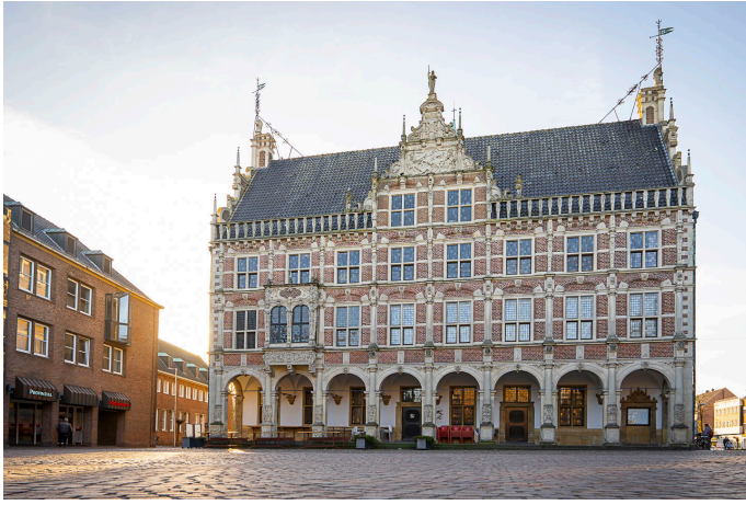
Historisches Rathaus: Bis Mitte der 1890er Jahre war rechts im Erdgeschoss die Polizeiwache untergebracht, in den Obergeschossen bis 1911 das Amtsgericht. Über der Wache gab es zwei Arrestzellen. Das Polizeigefängnis befand sich am Ostertor
